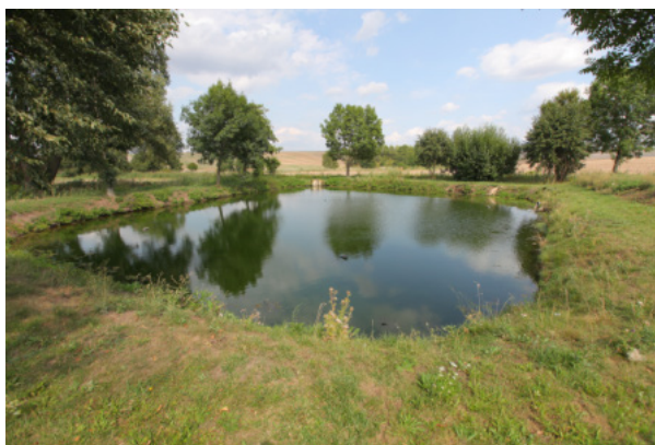
Obr. 13: Stabilizačná nádrž pre 750 EO
