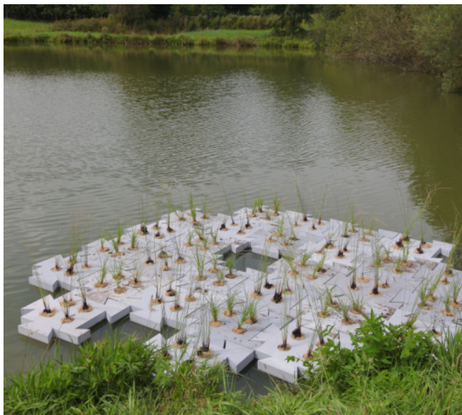
Obr. 15: Patentované riešenie pre stabilizačné nádrže – plávajúce ostrovy s mokraďovou vegetáciou
