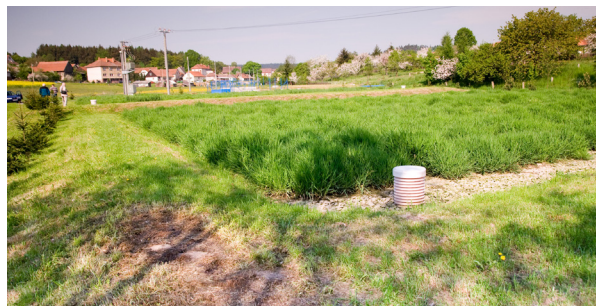
Obr. 12: Pohľad na horizontálny filter
