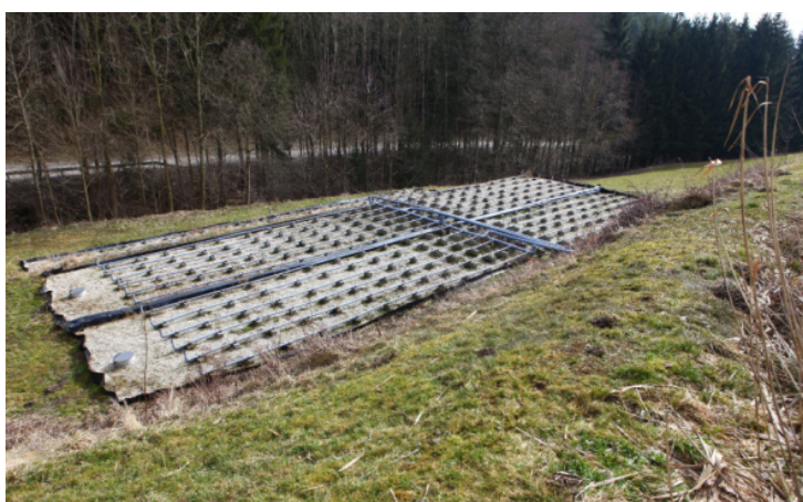
Obr. 10: Vertikálny filter po vykosení a žatve rastlín (marec). Za necelé dva mesiace potrubia „zmiznú“ pod novou vegetáciou.
